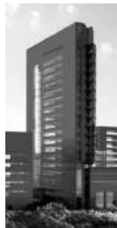
図 13 - 建物の外装としてのほうろうパネル
