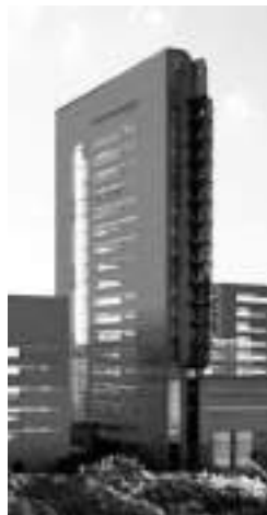
图 13- 搪瓷面板用作建筑外层
